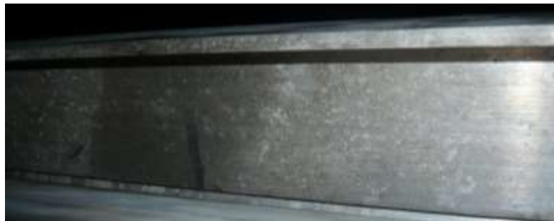
图 14 表面腐蚀
